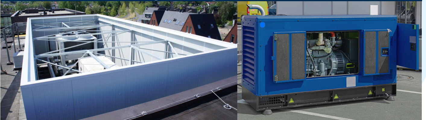
Einhausungen und Lärmschutzwände
