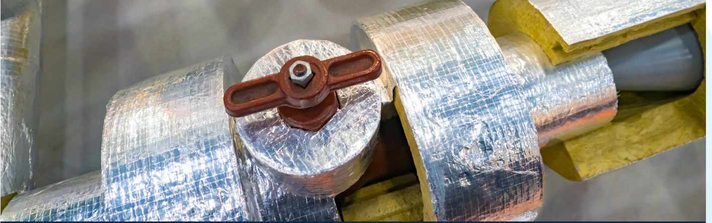
Abwasserrohre und Kanäle
